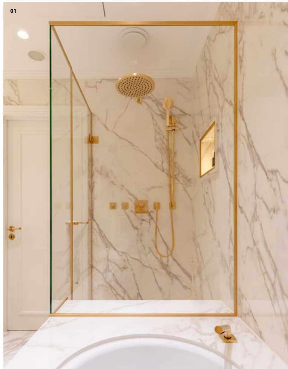
01 Gerade solche Sonderlösungen sind für das erfahrene Montageteam vom Ahrensburger Glasbau immer eine gerne gesehene Herausforderung 02 Formschön angepasste Profilelemente auch in der Innenansicht der Duschanlage.
