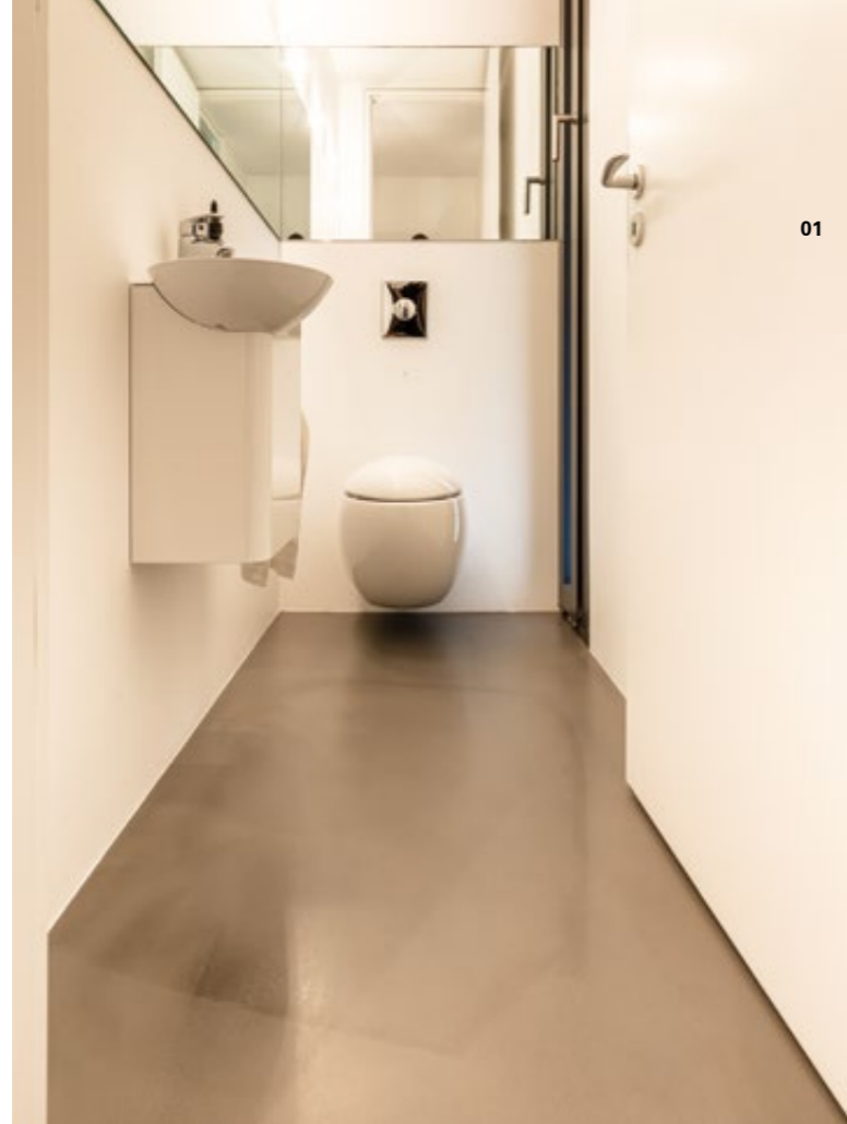
01 Pandomo wurde ebenfalls im Gäste-WC vergossen. 02 Das Hauptbadezimmer zeigt sich auch fugenlos mit Pandomo und handgespachtelten Wänden wurden in fusion.
