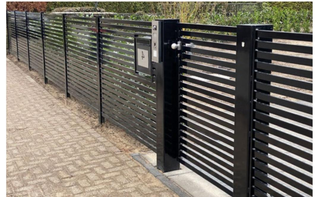
**01** Waagrechte Rechteckprofile werden zwischen zwei seitlichen Flachstahlprofilen im Abstand von ca. 25 mm verschweißt. **02** Rechteckrohrprofile werden schräg zwischen zwei seitlichen Flachstahlprofilen verbaut.
